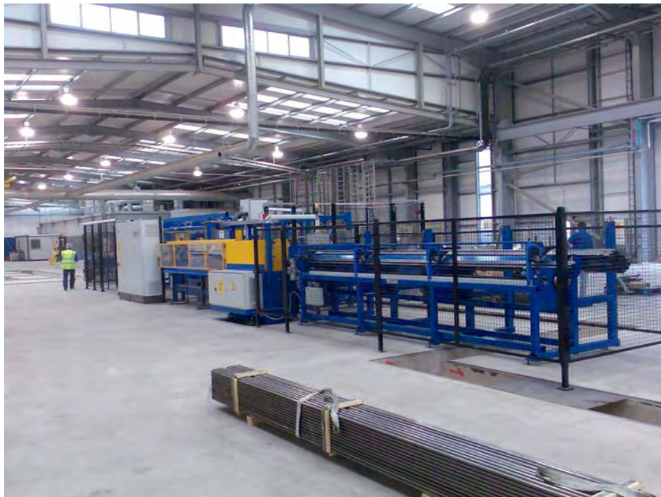
RTA 75 mit Bündellader (im Vordergrund am Boden liegendes Rohrbündel)
